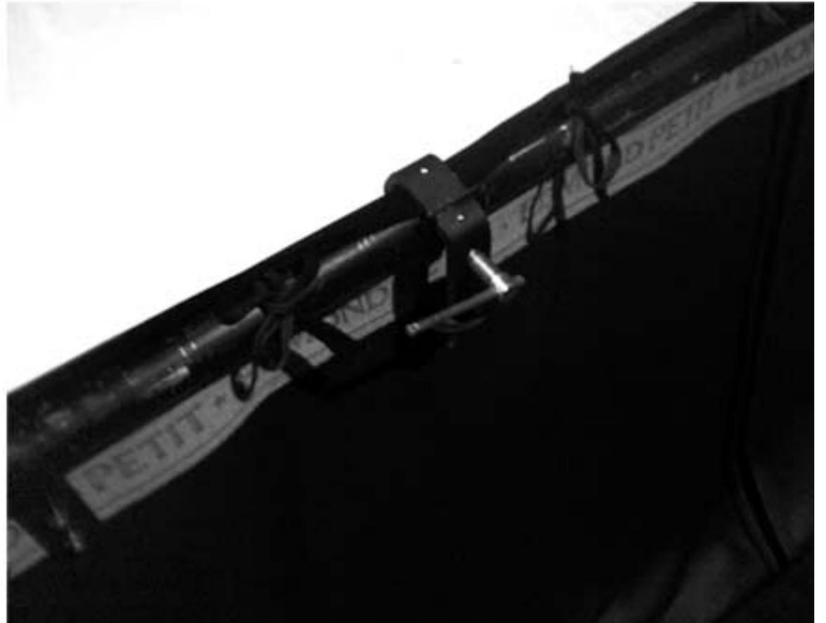
Systeme de réglage de la hauteur des pendrillons de la boite noire à l'allemande
